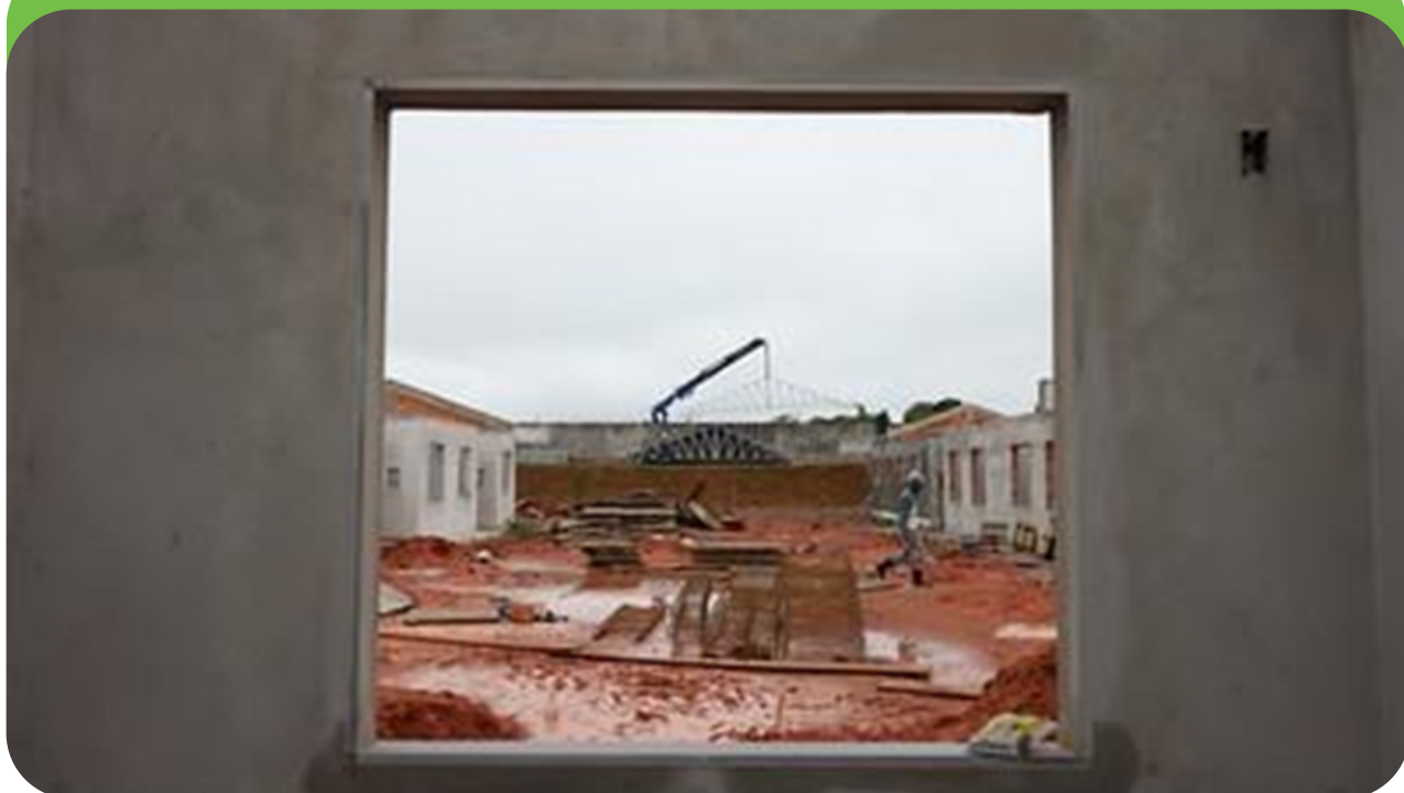
Obra da EMEI Monte Bello - Bairro Camobi
