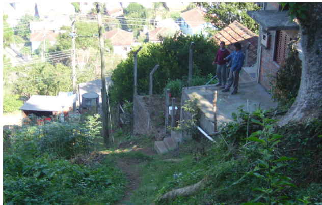
Figura 049 - Bela Vista, segundo setor - edificação 020.
