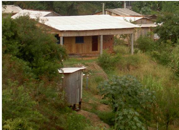
Figura 064 - Margens da Ferrovia junto ao viaduto da rua Euclides da Cunha, setor 1- edificação 015.
