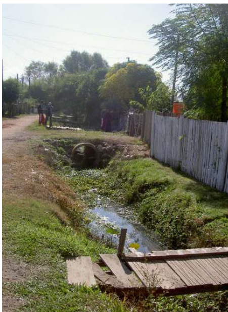
Figura 030 - Vila Ecologia, primeiro setor - vala de escoamento de águas servidas e pluvial.
