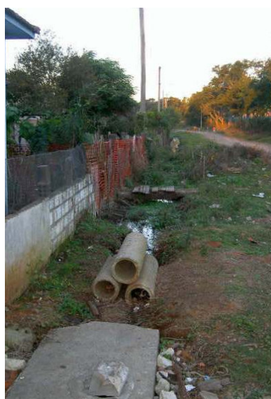
Figura 082 - Vila Favarin, segundo setor - vala de escoamento de água servida e pluvial.
