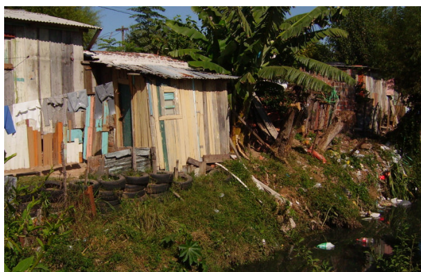
Figura 033 - Vila Santos, primeiro setor - fundos das edificações 005 e 006.
