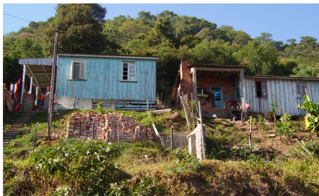
Figura 051 - Bela Vista, quarto setor - edificações 033 e 034.
