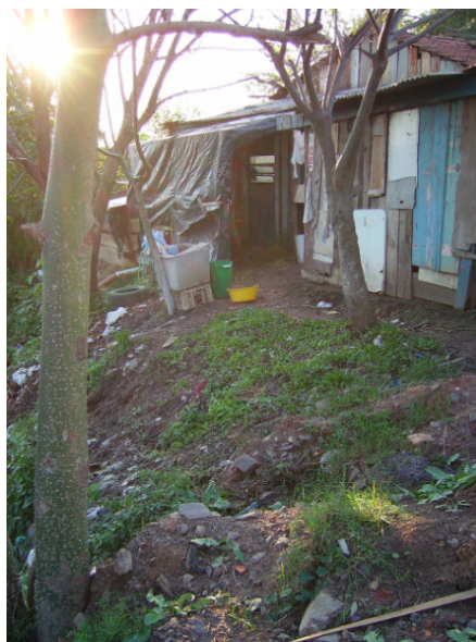
Figura 021 - Vila Arco-Iris, terceiro setor - edificação 022.
