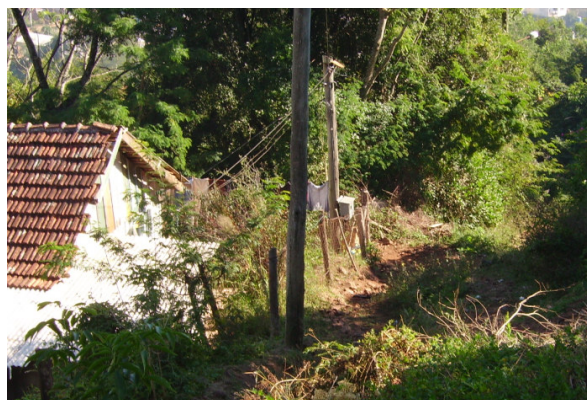
Figura 048 - Bela Vista, primeiro setor - edificação 005.
