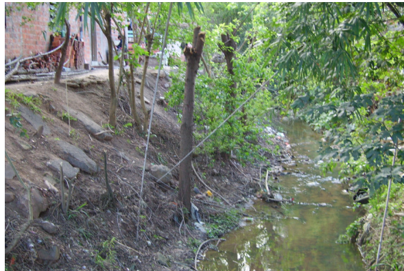
Figura 001 - Vila Cerro Azul, primeiro setor - fundos edificação 001, as margens de uma das nascentes do Arroio Cadena.
