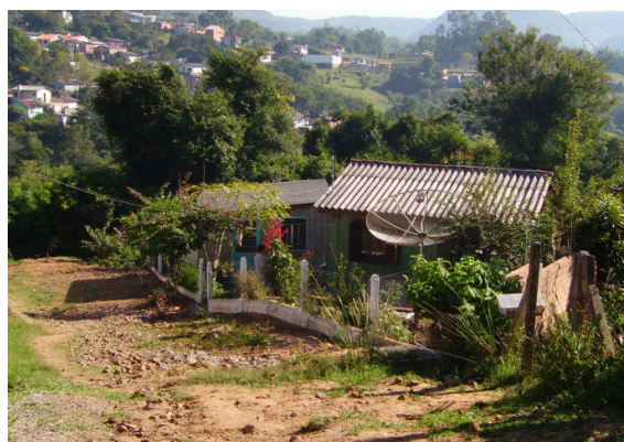
Figura 053- Bela Vista, quinto setor - erosão no acesso a edificação 086.
