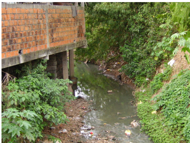
Figura 037 - Vila Medianeira - contenção de talude com uso de pneus.
