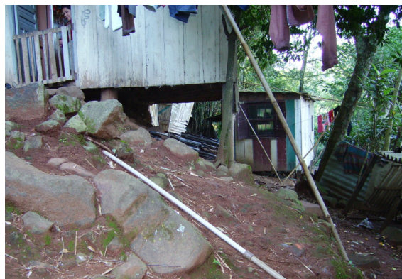
Figura 069 - Vila Schirmer, segundo setor - edificação 011.
