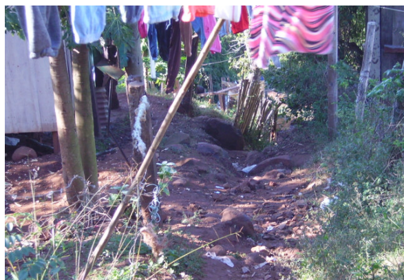
Figura 060 - Montanha Russa, sexto setor – erosão no acesso a edificação 039.
