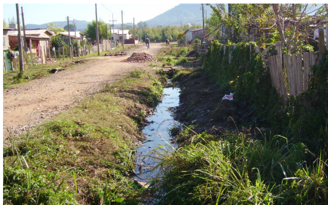
Figura 011 - Km2, vala de escoamento de água servida e pluvial.
