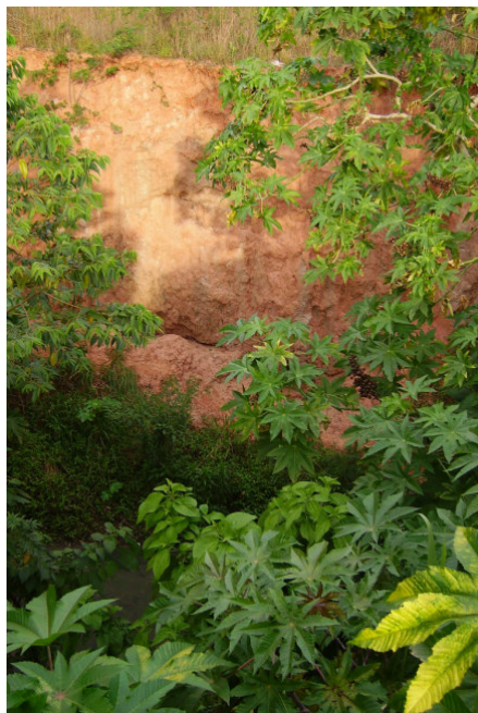
Figura 042 - Vila Nonoai - erosão do talude da margem esquerda do arroio.
