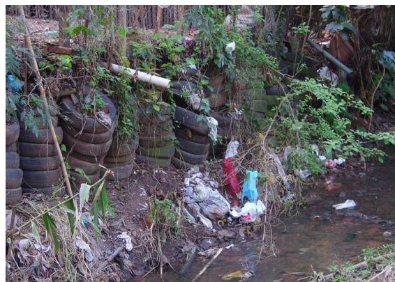
Figura 002 - Vila Cerro Azul, segundo setor - fundos edificação 033, contenção de talude com pneus.
