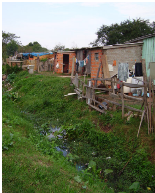
Figura 085 – Margem da BR 287 - trecho 1, vala de escoamento de águas servidas e pluviais paralela a BR 287 nos fundos das edificações 001 a 010.
