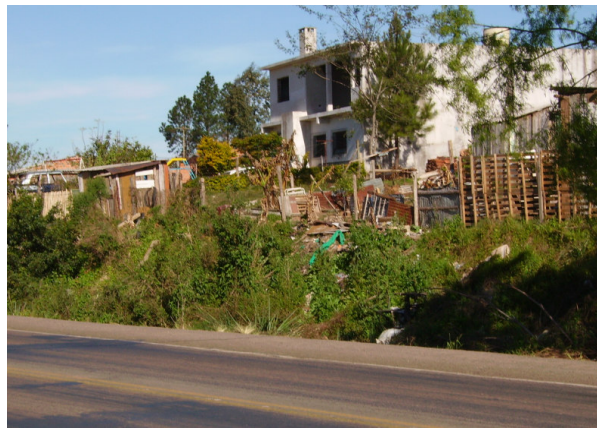
Figura 092 – Margem da BR 287 - trecho 3, aspecto do padrão construtivo das edificações na faixa de domínio da Rodovia.
