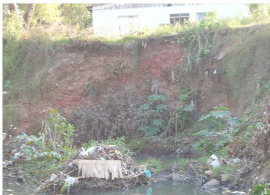
Figura 007 - Margens do Arroio Cadena, segundo setor - solapamento de margem e assoreamento do canal.
