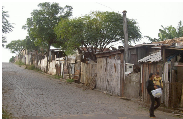
Figura 044 - Passo Dos Weber, primeiro setor - edificações 001 a 006.
