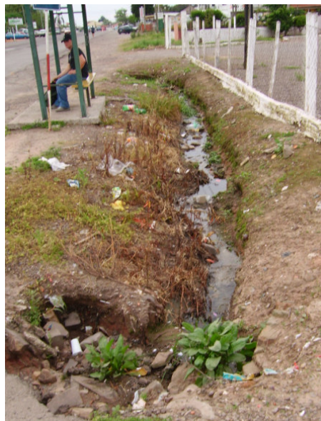
Figura 090 – Margem Da Br 287 - Trecho 2, Vala De Esgoto À Margem Da Rodovia.
